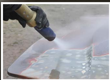
Fjerning av belegg og maling
