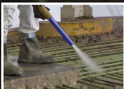
Reparasjon og restaurering av betong
